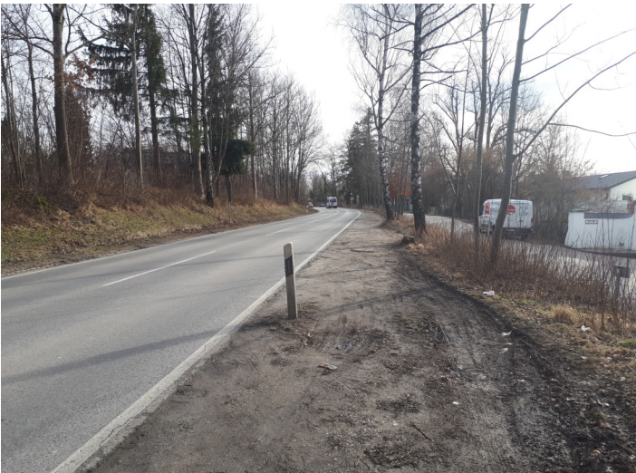
Notdürftig befestigter Haltestreifen entlang der St2070 (Blick von Norden aus in Richtung Berg) [5]
