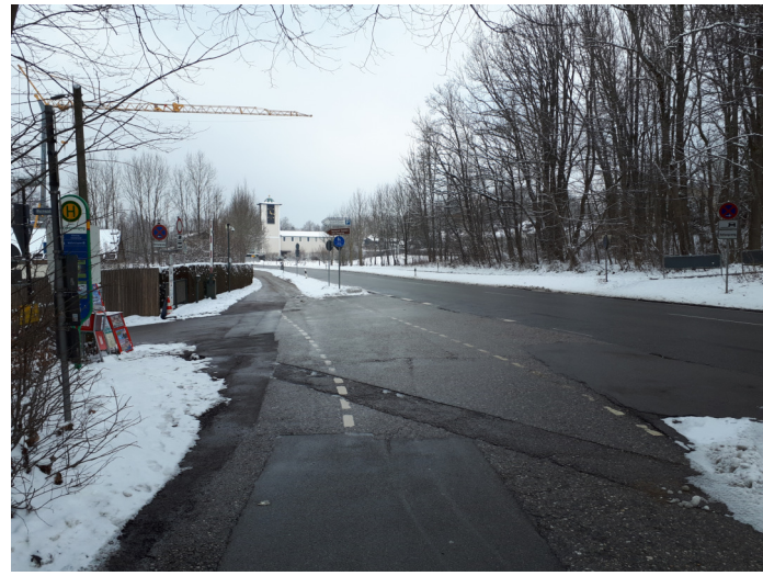
Kreuzung als Zufahrt zum Betriebsweg mit Bushaltestelle „Bucentaurweg“ (Blick von Süden aus in Richtung Starnberg) [3]
