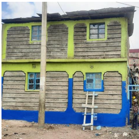
Unser zweites Schulgebäude direkt gegenüber der schon vorhandenen EFYE-Räumlichkeiten. Zum Mittagessen können die Kinder hinüber ins Hauptgebäude gehen.
