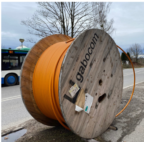
Und weiter geht's mit der Digitalisierung vor Ort: Seit vergangem Wochenende werden neue Glasfaserkabel in der Ortsmitte von Berg verlegt.
